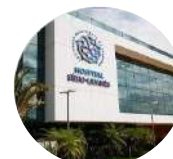
Hospital Asa Sul
